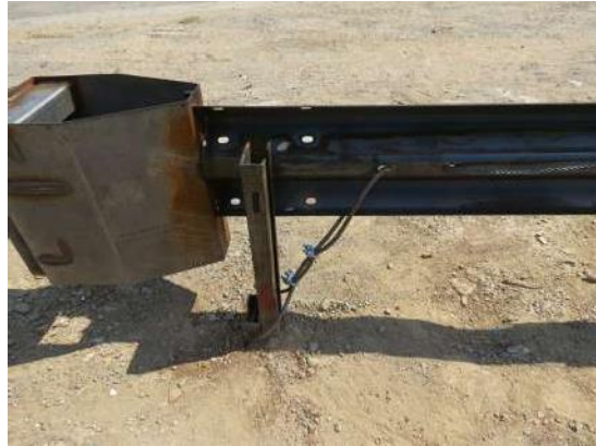
Figura 4 – Detalhes fixação no terreno / Ground fixing details
