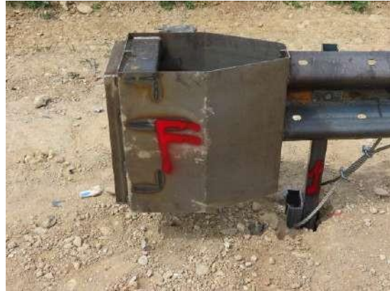
Figura 4 – Detalhes fixação no terreno / Ground fixing details
